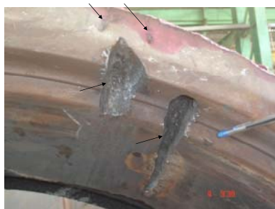
Gambar-2 Retak pada RTG
