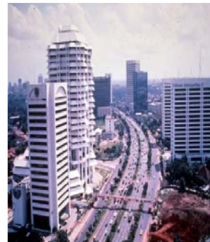
Gambar 6 Ruang Terbuka Disekeliling Bangunan Disediakan Bukan Untuk Kawasan Hijau Tetapi Untuk Parkir Kendaraan.
