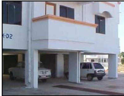
Gambar 1.1 Bangunan Gedung Beton Bertulang dengan Tingkat Dasar Terbuka
