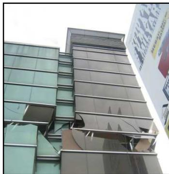
Gambar 1.3 Keruntuhan Tingkat Lunak pada Bagian Tengah Gedung
