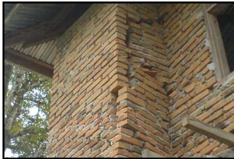
**Gambar 1.2** Retak pada dinding tanpa kolom akibat beban gempa
