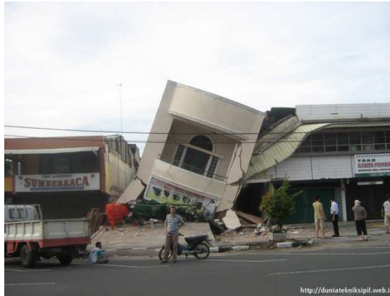
Gambar 1.1 Soft-storey di lantai satu
