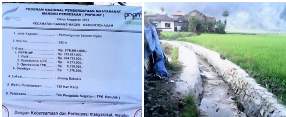
Gambar 2.1 Program Pembangunan Irigasi PNPMP Mandiri Perdesaaan
