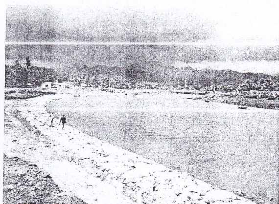
Gambar 7 : Pekerjaan batu besar (boulder) rip – rap pada sisi kanan dan kiri aliran Batang Anai
