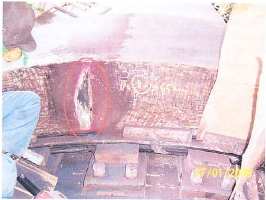
Gambar 1 Retak yang terjadi pada live ring
